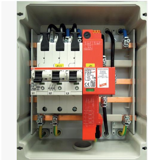
**Überspannungsschutzeinrichtungen für Zähleranschlussäulen (Direktmessungen)**
