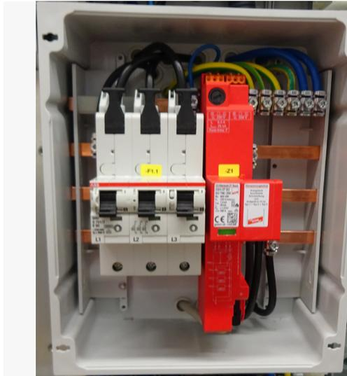
**Überspannungsschutzeinrichtungen für Zähleranschlussäulen (Direktmessungen)**
