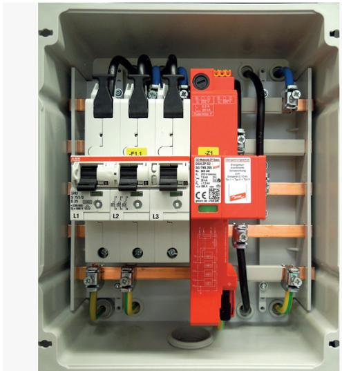
**Überspannungsschutzeinrichtungen für Zähleranschlussäulen (Direktmessungen)**
