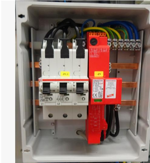
**Überspannungsschutzeinrichtungen für Zähleranschlussäulen (Direktmessungen)**
